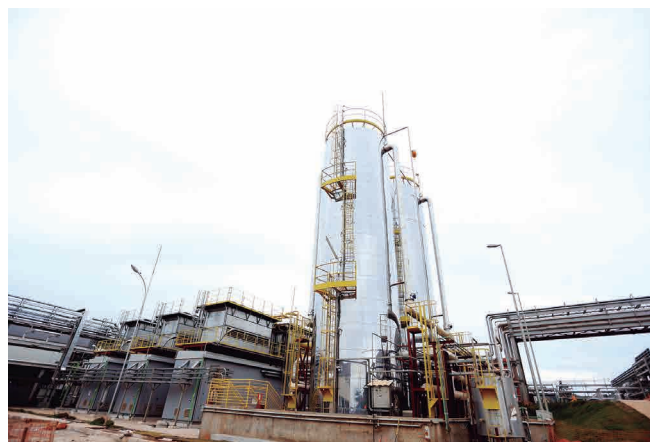
Mayekawa - Sistema de Resfriamento Indireto com Reservatório de Termoacumulação Estratificada
